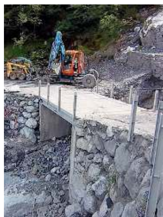
Cantieri. Lavori sul ponte
